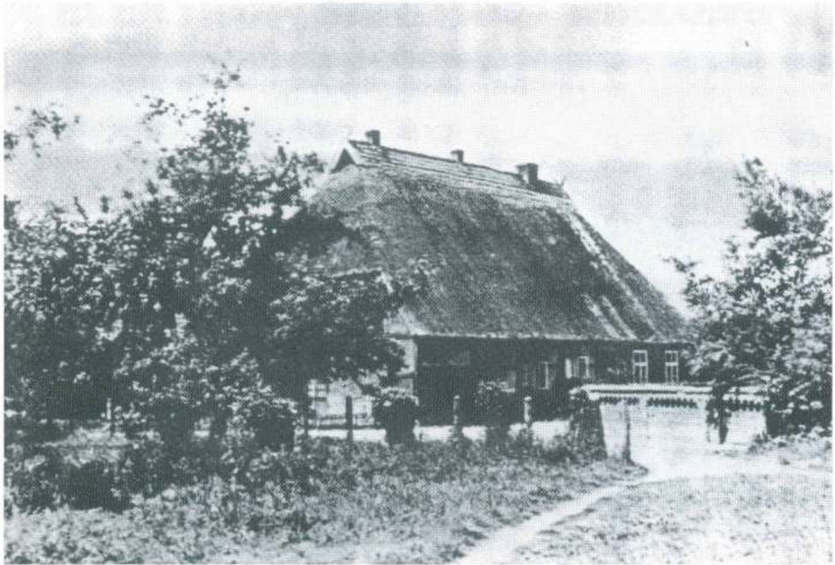
Küsterei: Schulhaus bei der Kirche, erbaut 1782
